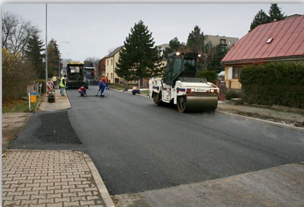
7 VÁLCE DOKONČUJÍ POVRCH
